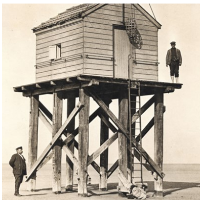
1865 wordt het eerste vluchthuisje voor schipbreukelingen op de Boschplaat van Terschelling neer gezet. In het huisje kunnen de schipbreukelingen schuilen tot zij gered kunnen worden bij gunstigere weersomstandigheden of getij. Er volgen nog meer vluchthuisjes op de Vliehors van Vlieland, de Engelsmanplaat bij Schiermonnikoog en de Boschplaat bij Rotterdam.
